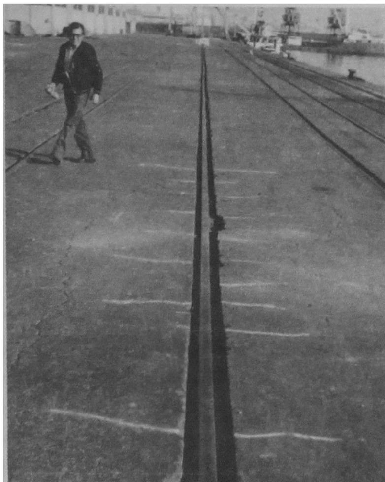
Fig. 6. Riel de tierra con agrietamiento transversal sistemático cada  $0.90 - 1.0 \text{ m}$  de espaciamiento.
