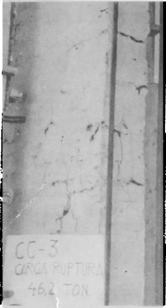
Fig. 8. Muro Ch 3s, compresión.
