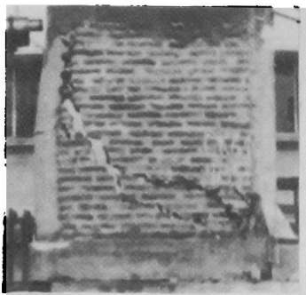
Fig. 21. Muro Ch 6s, en voladizo.
