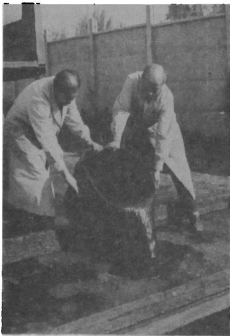
Fig. 4. Vertiendo la lechada asfáltica en la cancha de prueba de La Florida.
