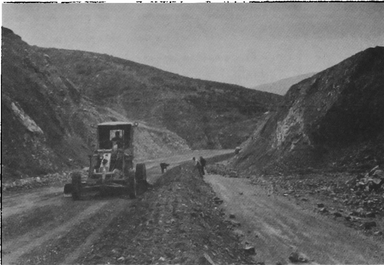
Fig. 3. Motoniveladora acordonando y revolviendo material de base (Carretera Panamericana. Sector Juan Soldado - Incahuasi).
