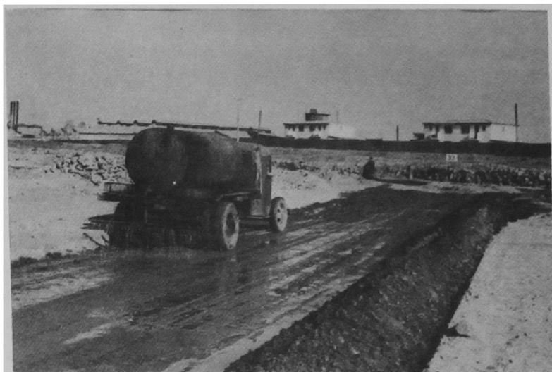
Fig. 4. Camión regador, regando el material de sub-base (Camino Villarica-Loncoche).
