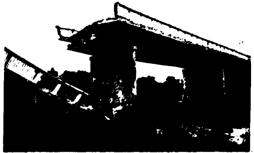
Fig. 2. Puente Pullalli, falla de la articulación en la viga Gerber con la consiguiente caída del tramo simplemente apoyado.
