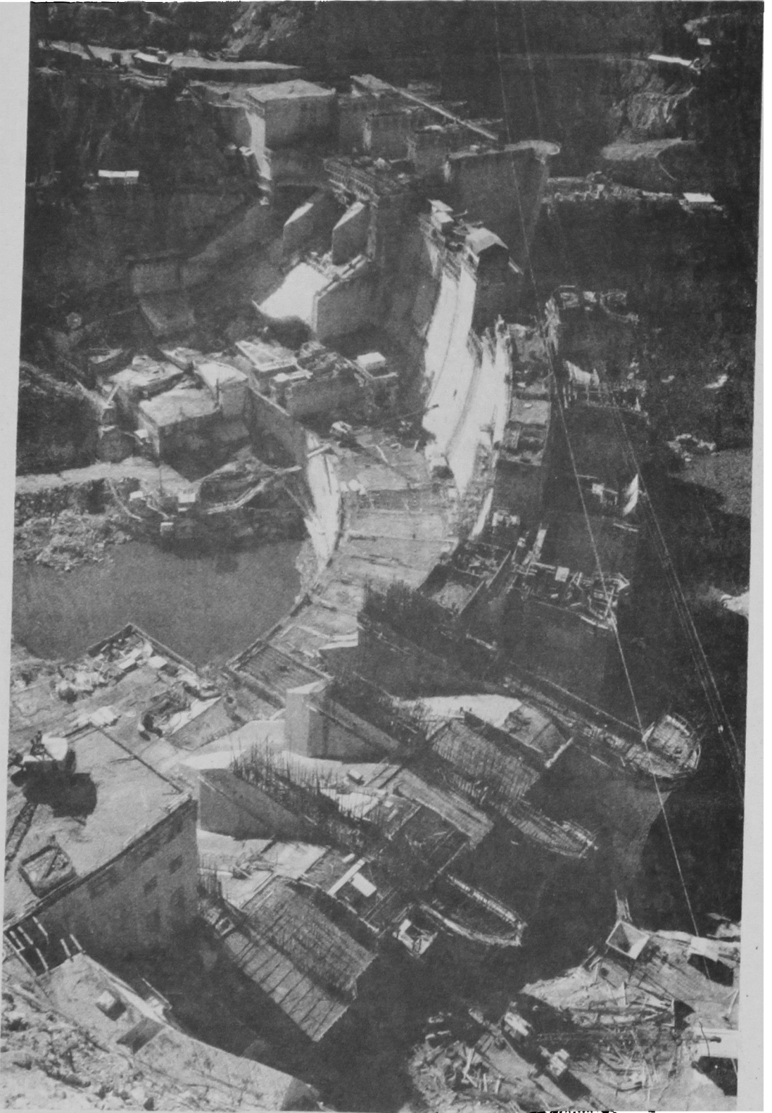
Fig. 8. Muro en construcción
