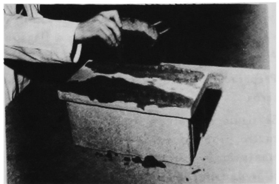
Fig. 4. El mortero se esparce sobre el bloque inferior en forma de cordones paralelos.
