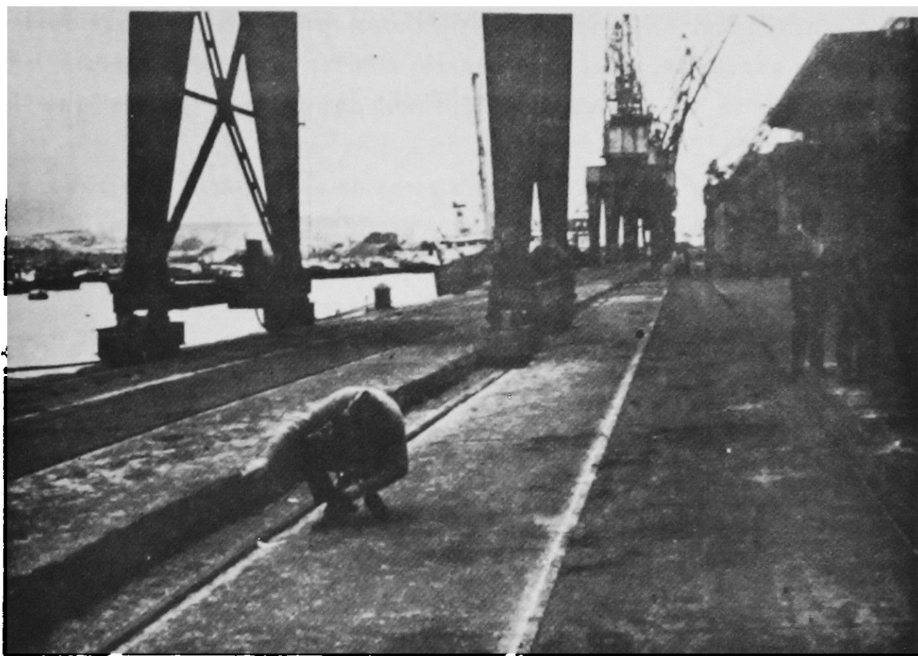
Fig. 2. Asentamiento en el relleno del Molo, San Antonio.
