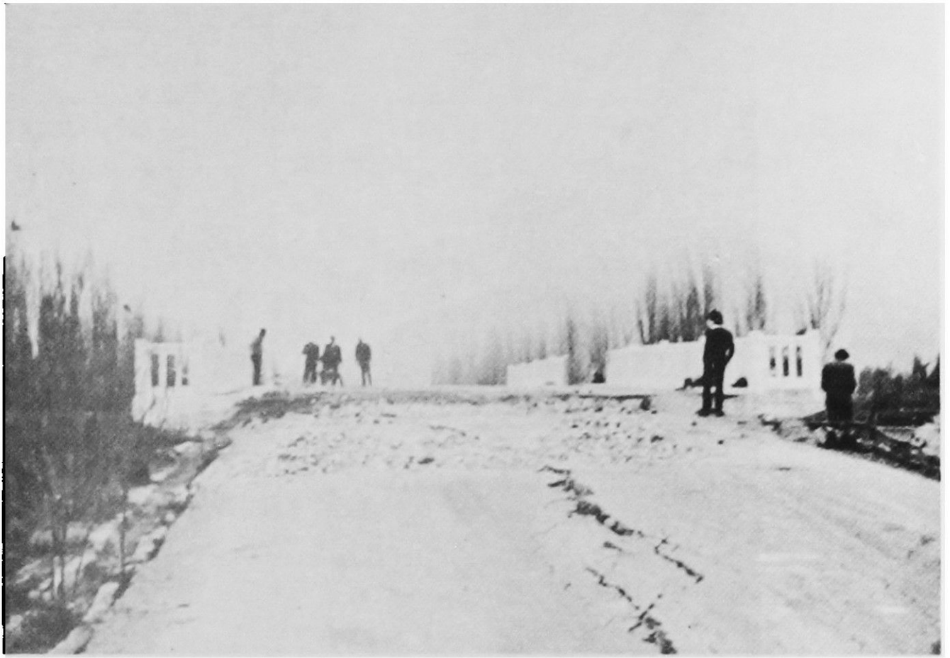
Fig. 5. Descenso terraplén de acceso a puente de Carretera Panamericana, Llay Llay.
