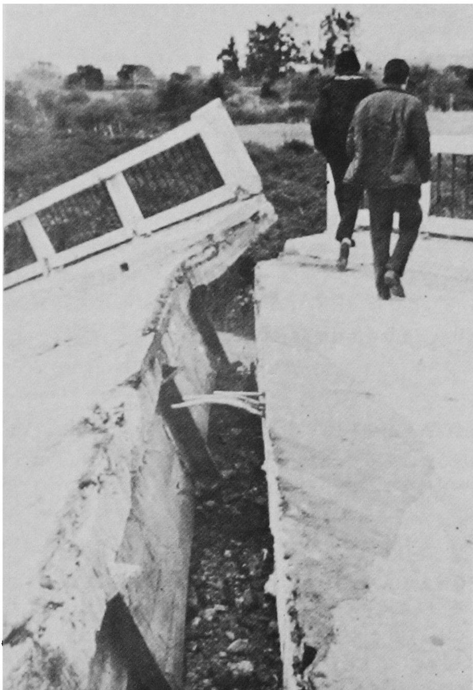
Fig. 3. Detalle de uno de los apoyos del puente Pullalli.
