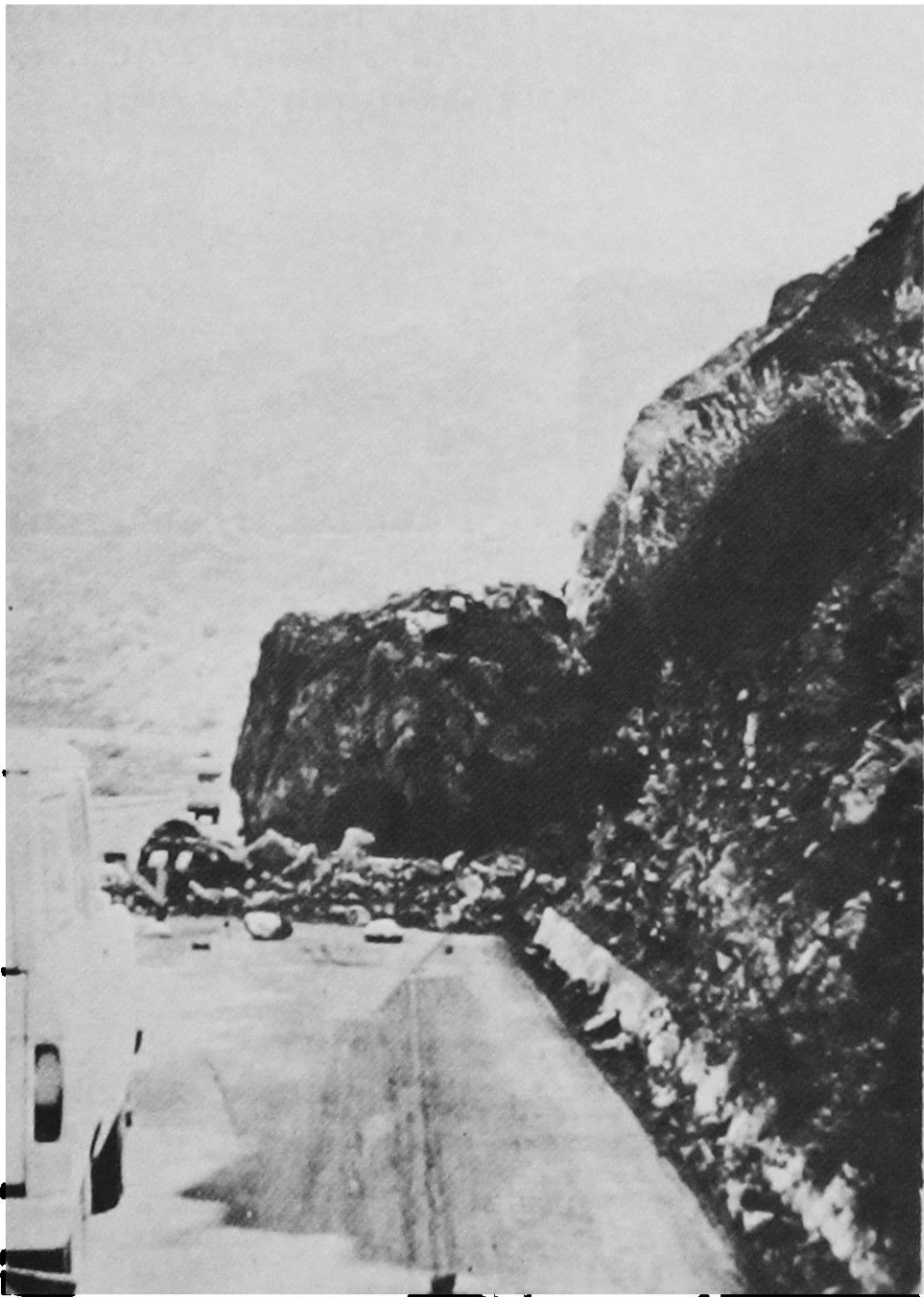
Fig. 4. Deslizamiento de roca en Las Chilcas.
