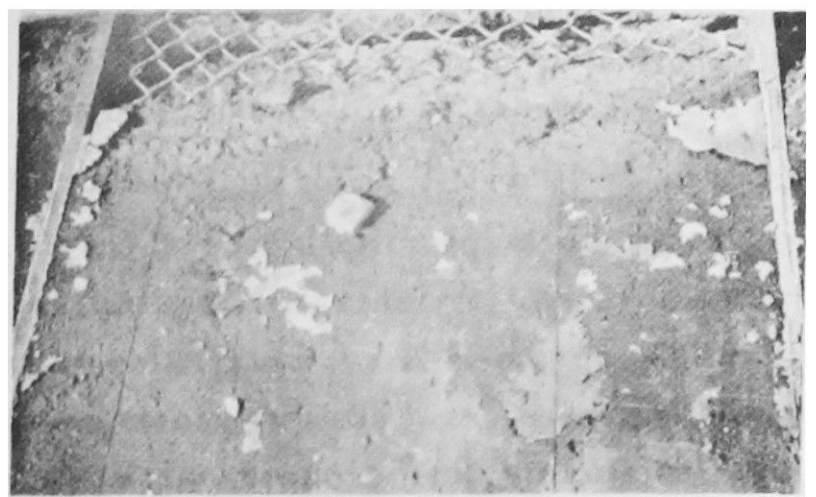
Fig. 2. Prueba de relleno bajo malla de sustentación.
