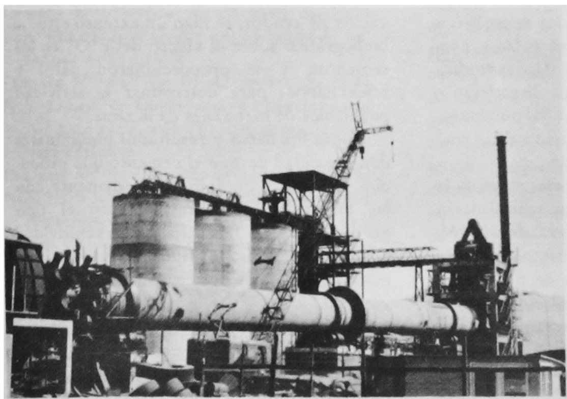
Hornos y silos de alimentación de crudos.
