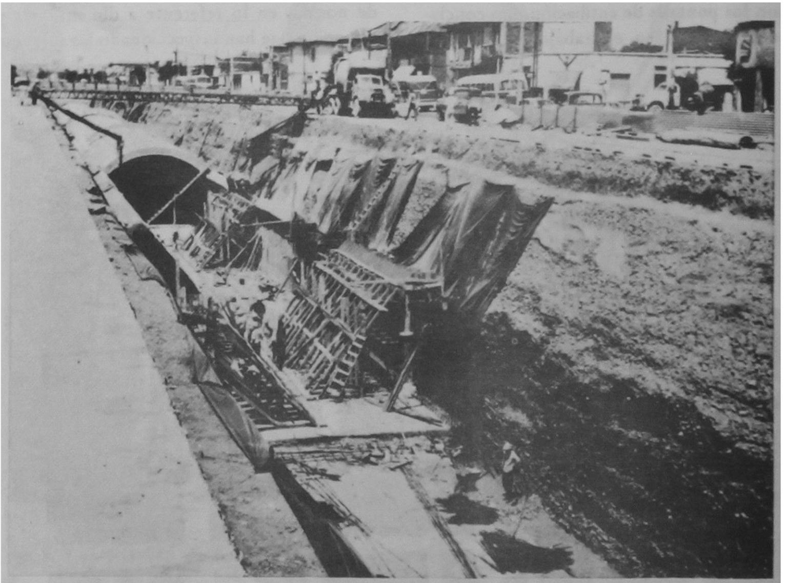
**Fig. 1.** Vista de la zanja excavada de la línea 1 del Metro de Santiago. Se observan muro laterales en vía de construcción y al fondo, la zanja abovedada.
