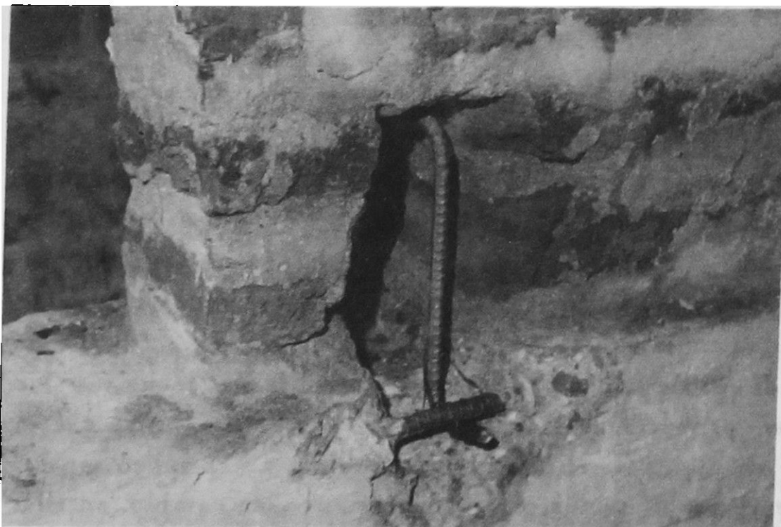
Fig. 8. Reparación con llaves de hormigón.
