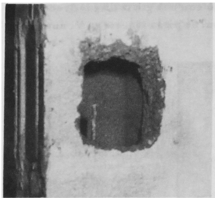
Fig. 11. Reparación de un murito de bloques con tarugos de hormigón.
