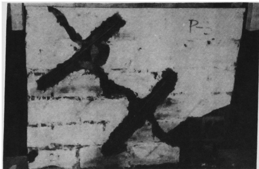
Fig. 16. Reparación de grieta diagonal de un murito de ladrillos rejilla con costuras de hierro.
